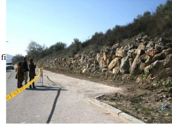
Evitar la entrada y acumulación de lodos y aguas pluviales en los viales del Polígono de La Vega es el objetivo de la construcción de un muro de contención, que actualmente está ejecutando el Consistorio prieguense, con una inversión de 60.000 euros,
