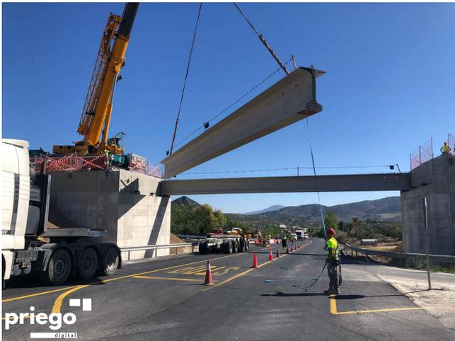
Hoy martes ha dado comienzo el montaje de las cuatro vigas prefabricadas que sustentarán el paso aéreo en uno de los tramos de concentración de accidentes de la A-339 a su paso por las inmediaciones de Priego en los que la Junta está interviniendo.
